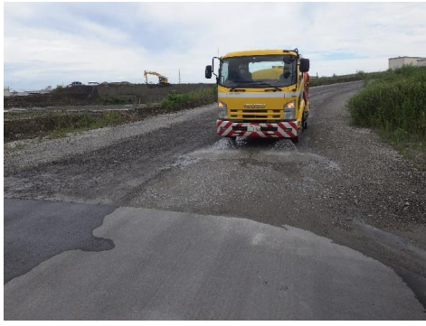
散水車による散水
