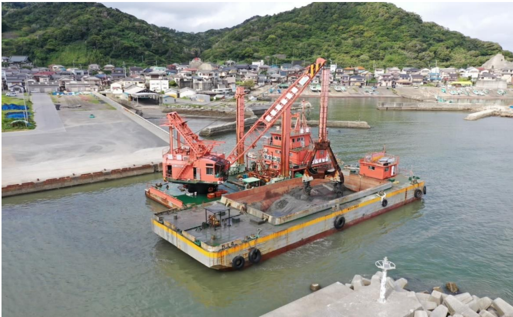
和田漁港 泊地浚渫工事
