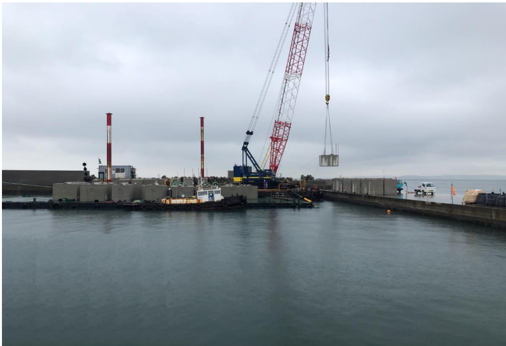
富津漁港下洲地区 防波堤工事
