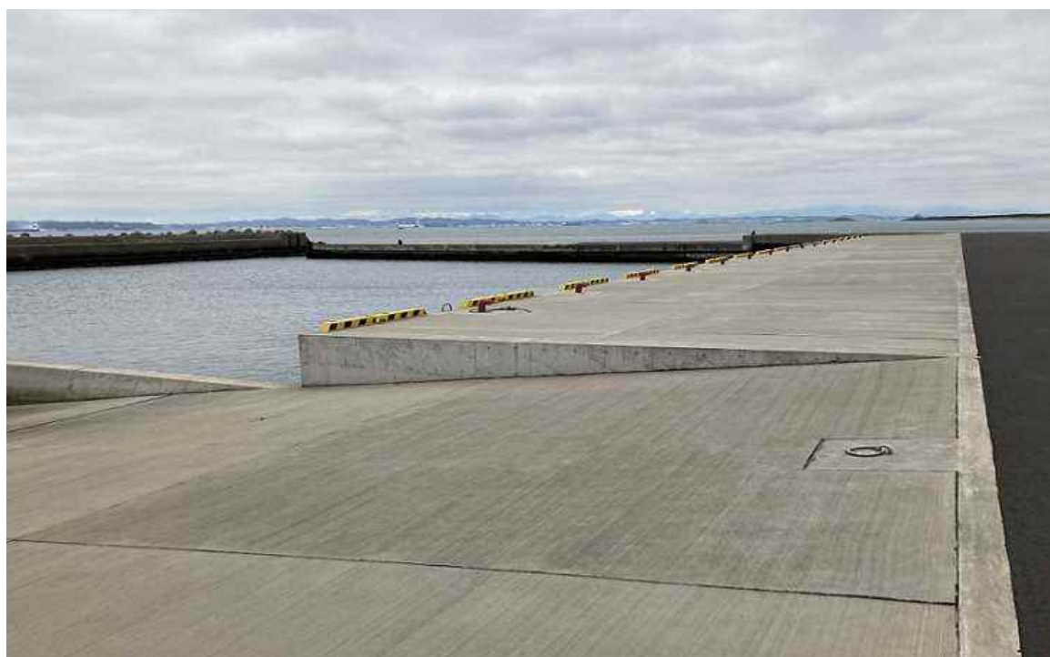
富津漁港下洲地区 -1.5m物揚場
