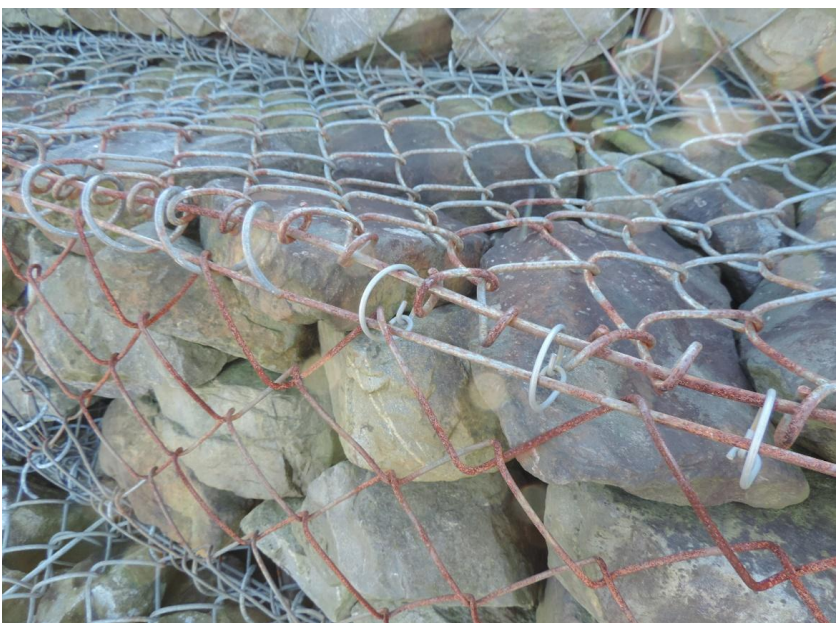
コイルと比較 Eリング間隔15cmにて施工例
