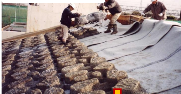
施工状況写真(据付後覆土)
