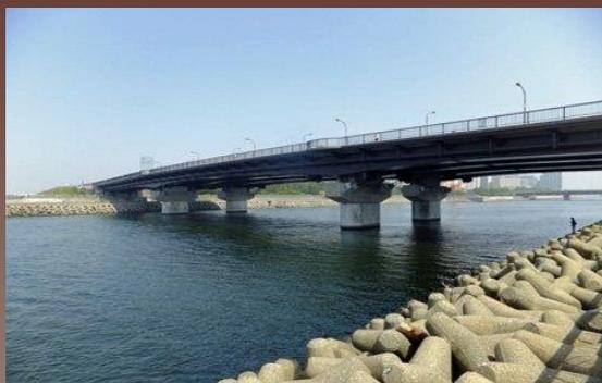
塩害地区で且つ耐候性鋼材が使用された同橋梁に対しプラスト処理+強溶剤形ふっ素仕様で塗替を実施。中でも**プラスト処理が難しく、早期発錆が予測される支承などの狭隘部（ケレン困難部）**に対しサビシャットを先行塗装した。
