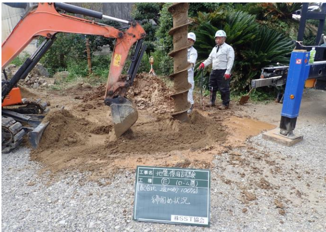
(b) オーガの上昇および地表面の締固め
