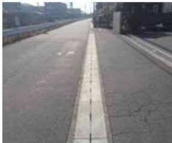
現場打ち側溝
