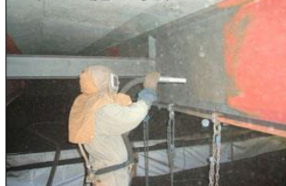
ブラスト施工状況
