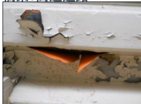
橋梁:高速道路
