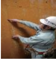
パネルの目違いを直したときの写真
