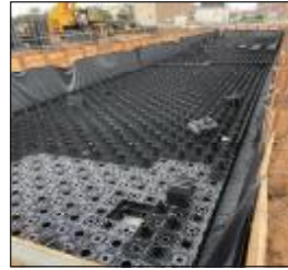
現場施工状況
