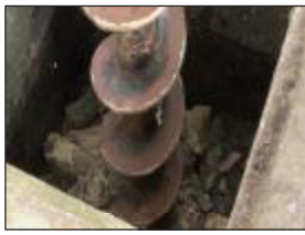
雨水枳掘削状況
