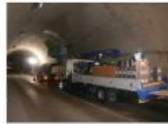
道路トンネル施工状況
