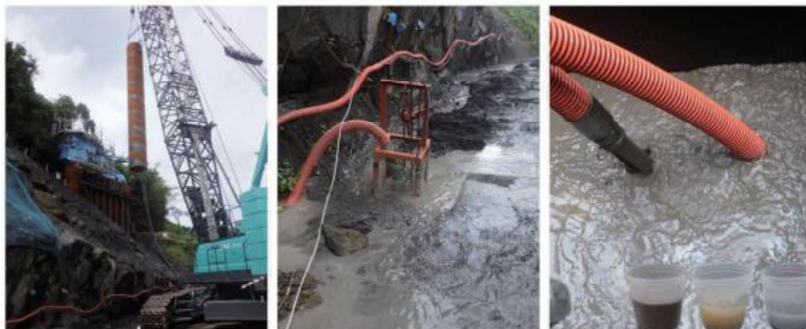
ウォータージェット併用法の様子。発生した大量の汚泥をポンプで吸い上げる。ポンプで吸い上げた汚泥を泥土と水に分離。処理水は再利用。
