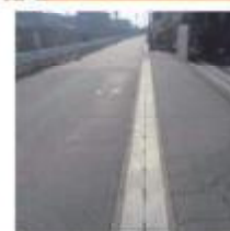
現場打ち側溝
