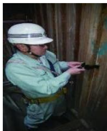
パネルの栈木の中央に45の釘を打って釘の頭にフラットキーパーを引っ掛けて調整している写真
