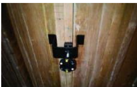
パネルの目違いを直したときの写真
