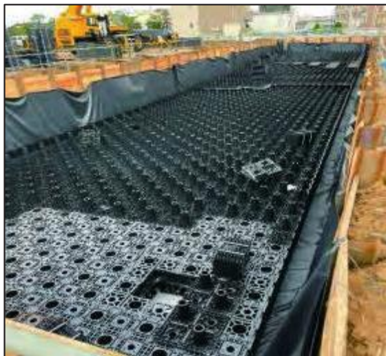
現場施工状況
