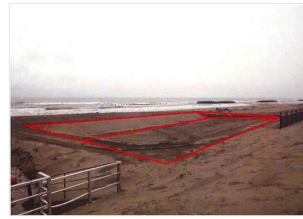
飛砂ポケット工
