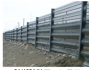
防潮防砂フェンス工
