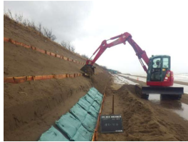
はまみどりマット施工中
