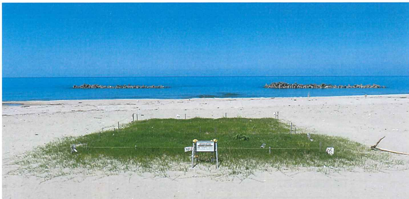
山形県湯野浜海岸試験施工（施工後15ヶ月）
