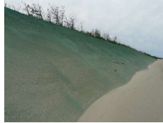
無機資材敷均し工・散布工
