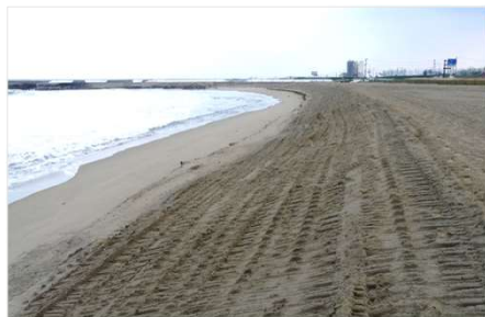
養浜工 飛砂対策が必要
