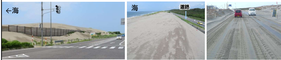
海岸道路にせまる砂山 冬期は道路上に砂が堆積（新潟市）
