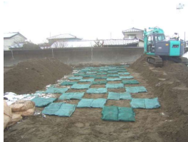
はまみどりマット施工中
