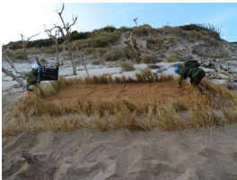
はまみどりマット施工中
