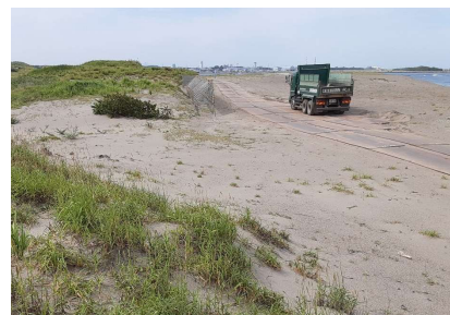
河口部工事 植生への影響（新潟市）
