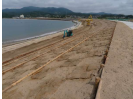
はまみどりマット敷設中
