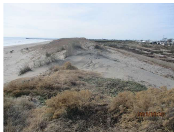
不安定な土堤、土堤の部分崩壊 （匝瑳市北九十九里地区・西浜ほか）
