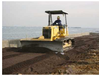
② ブルによる撒き出し
