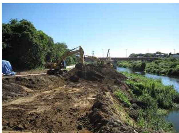
河川浚渫工事の例 (千葉県千葉市)
