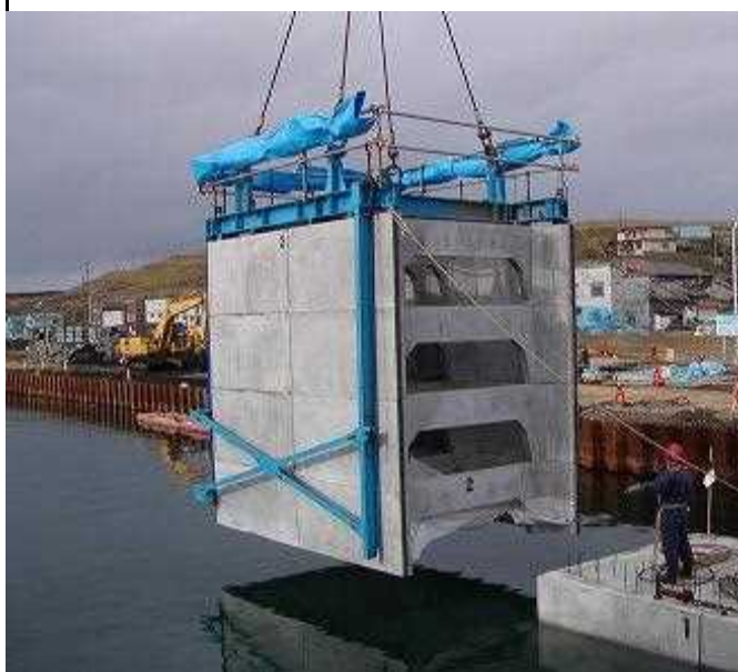
函体の据付け作業中
