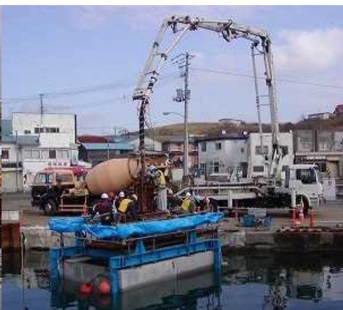
水中コンクリートの打設作業中
