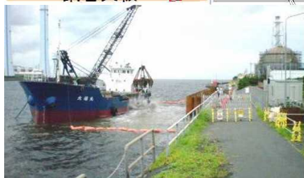
人工石材の施工状況
