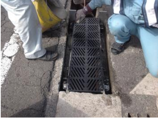
⑤ 端部調整、モルタル充填 (20分)
