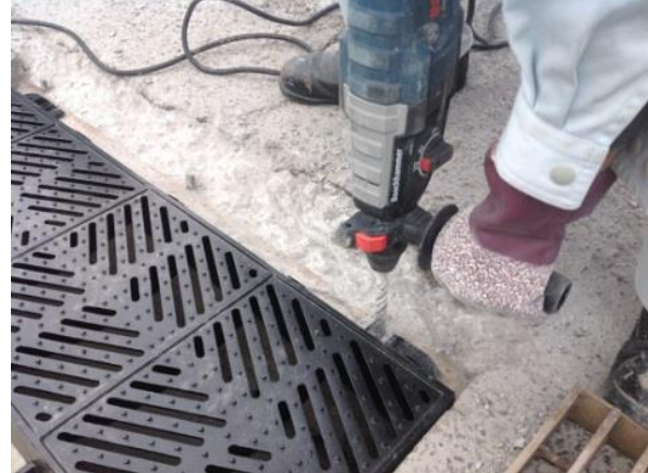
② 製品仮置後、ボルト穴削孔(15分)
