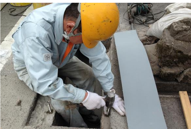
③ 高さ調整用ボルトの設置(5分)
