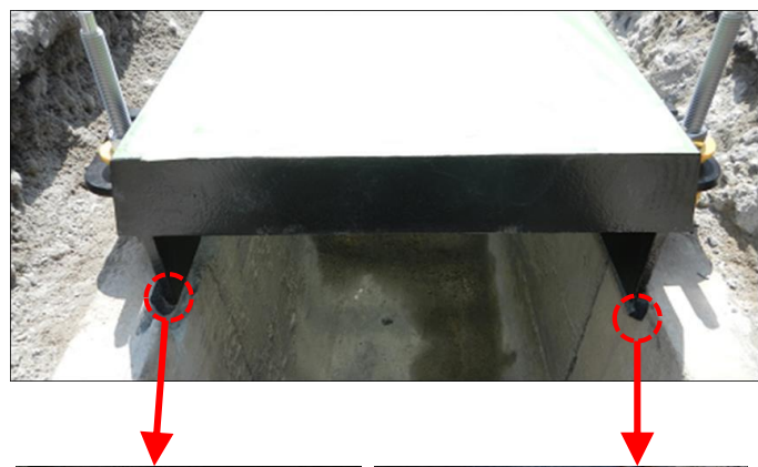
④ 製品を設置して高さを調節(10分)
