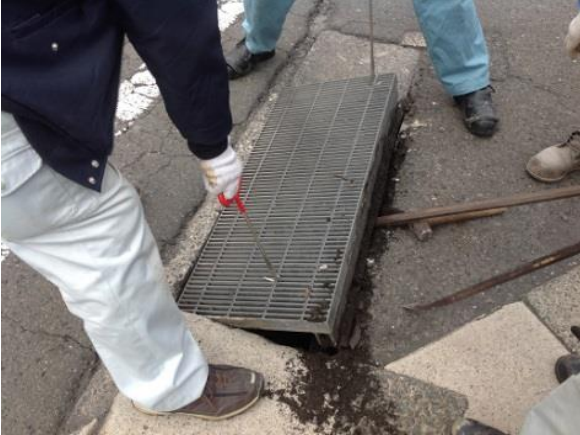
① 既設ふたを取外し受枠を撤去(30分)
