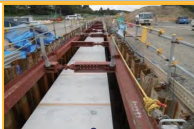
雨水管(ボックスカルバート)埋設
