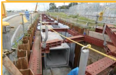
雨水管(ボックスカルバート)埋設
