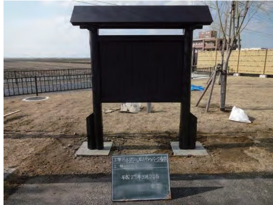
水郷佐原あやめパーク 看板にファインクリスタルウッド ® 施工
