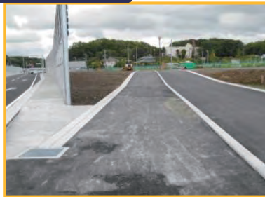
砕石(路盤)・舗装
