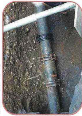
切断する铸铁管 (直径20cm)
