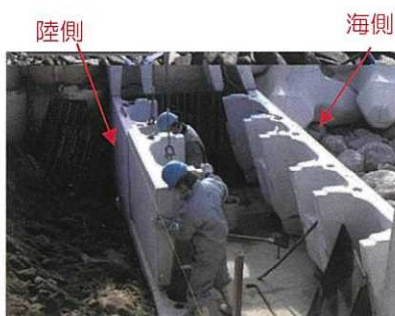
クレーンによるブロック組立作業
