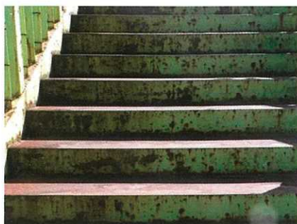
施工(素地調整)前
