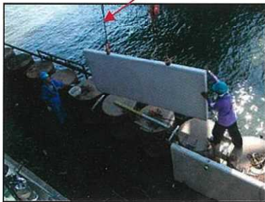
クレーンによる建込
