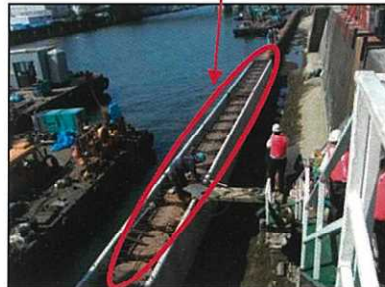
間詰コン打設 (水中コンクリート)
