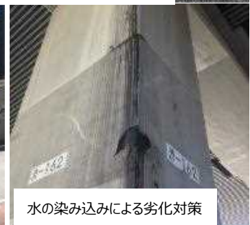
電柱 (動物の尿による劣化)
