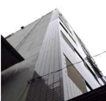
ビル外壁(5Fまでコーティング)
