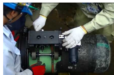
(3)油圧モーター一部の設置
