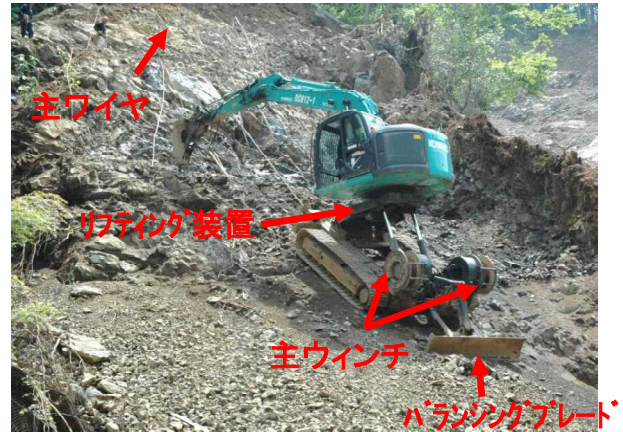
【高所法面掘削機】
