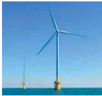
千葉県銚子市沖の洋上風力発電 [出典:新エネルギー・産業技術総合開発機構(NEDO)]
