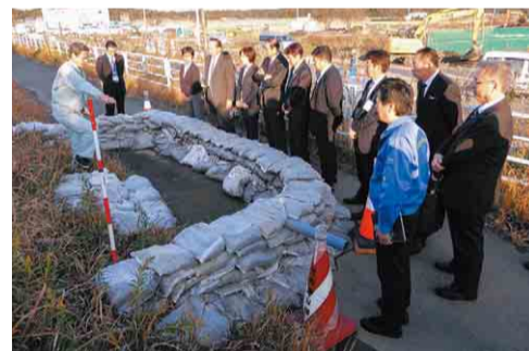
西印旛沼において水防工法(月の輪工法)の説明を受ける委員
