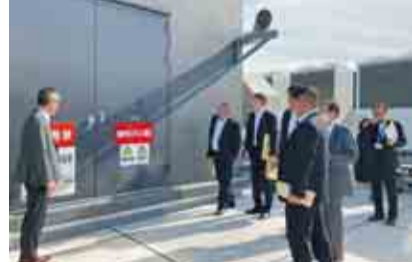
新しい合同庁舎の設備等について説明を受ける委員
