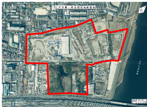
《江戸川第一終末処理場（建設中）》
