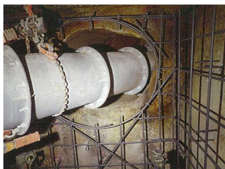
人孔（マンホール）の耐震補強
