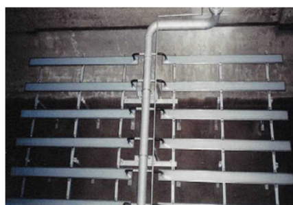
膜分散式散気装置
