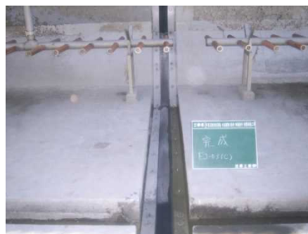
処理場施設の継手部の耐震化
