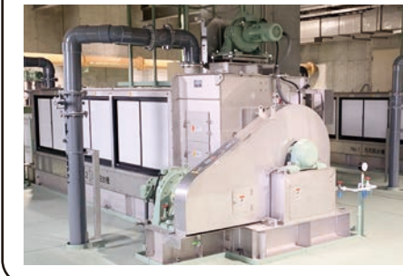
スクリーンプレス脱水機
