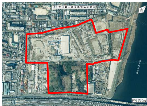
《江戸川第一終末処理場（建設中）》
