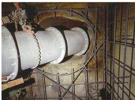
人孔(マンホール)の耐震補強
