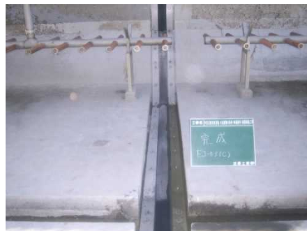
処理場施設の継手部の耐震化
