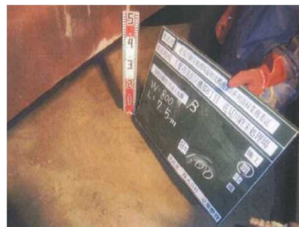
最初沈殿池への砂の流入
