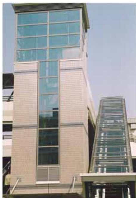
エレベーター、エスカレーター
