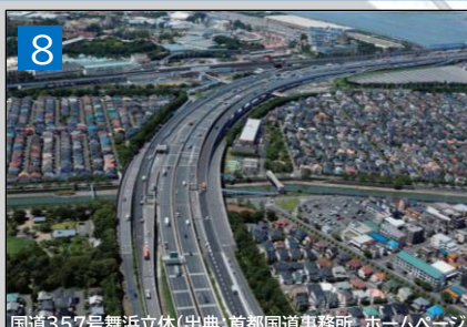
右：国道357号 東京湾岸道路(舞浜立体)
