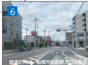
左：国道296号 交差点改良事業
