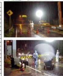
平成18年12月26日豪雨時の通行止めの様子 (上下写真：元名区間の金谷道断機)
