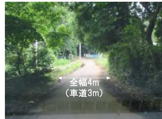
(主) 船橋松戸線 道路状況写真
