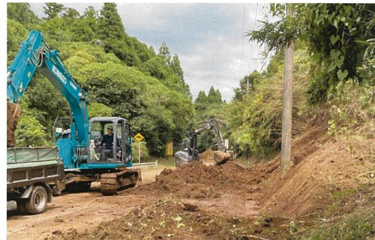
協力企業((一社)千葉市建設業協会)による復旧作業状況
