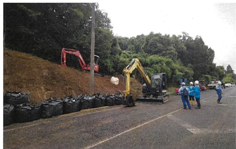
TEC-FORCEパートナー(清水建設)による復旧状況
