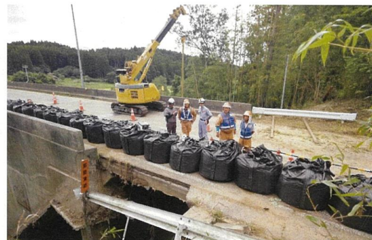
TEC-FORCEパートナー(大林組)との調査状況
