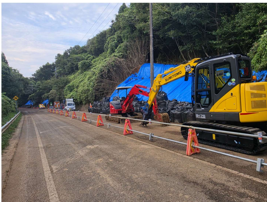
応急作業完了後 千葉市緑区越智町地先
