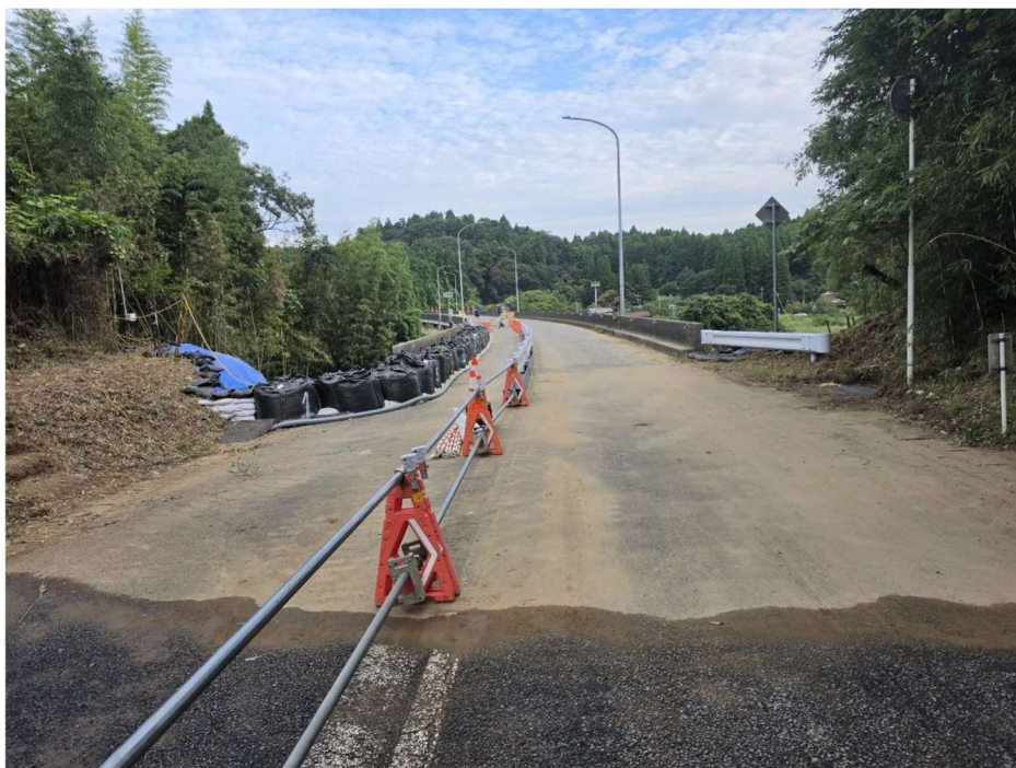
応急作業完了後 市原市瀬又(越智高架橋)地先
