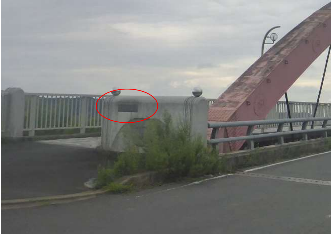
発生箇所⑤(盗難発生前)
