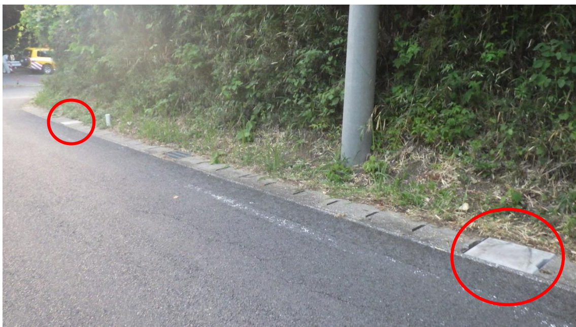
対応後（コンクリート蓋設置後）
