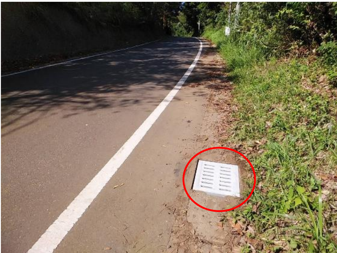
対応後（コンクリート蓋設置後）
