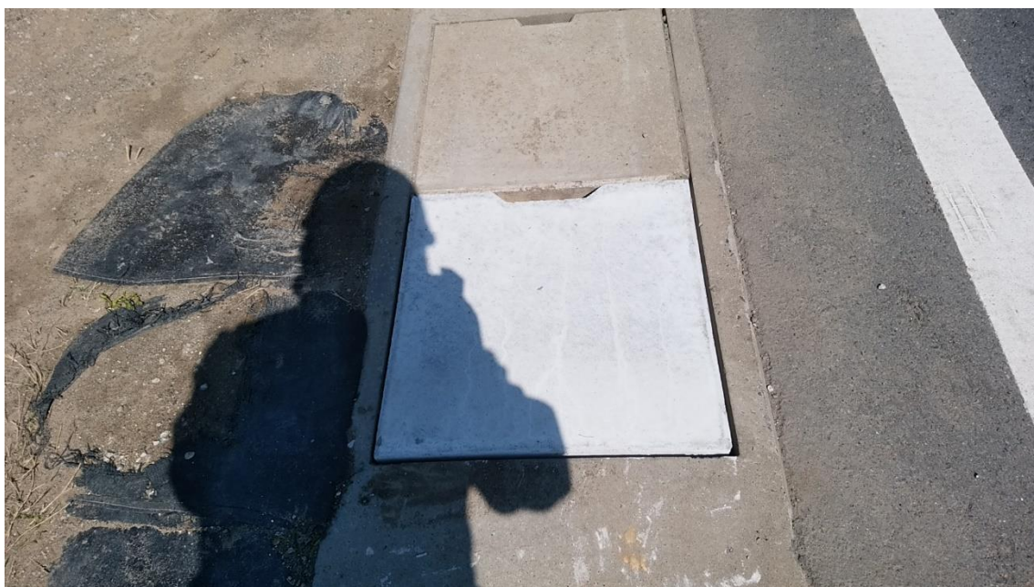
対応後（コンクリート蓋設置）
