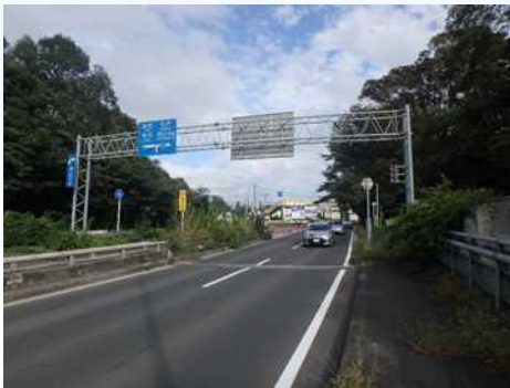
▲門型道路標識
