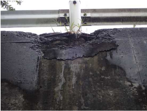
上部道路の防護柵基部のコンクリートが破損しています。
