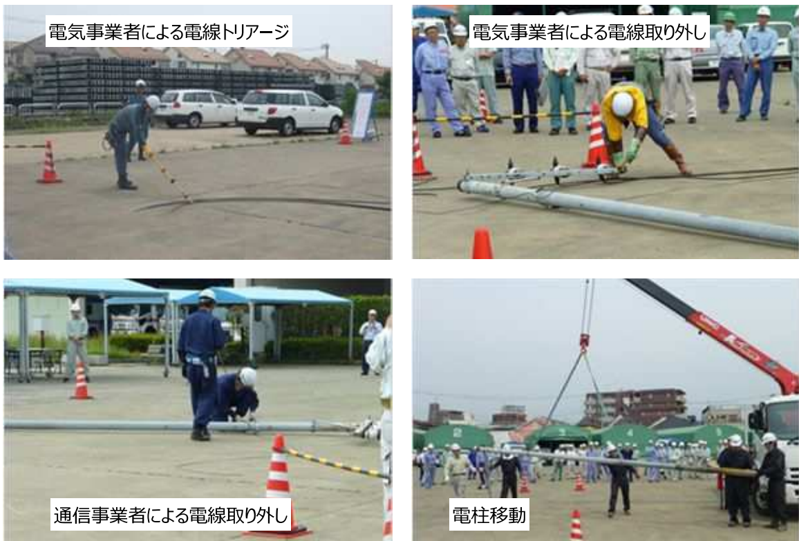
図 4.28 電柱の移動に関する作業例
