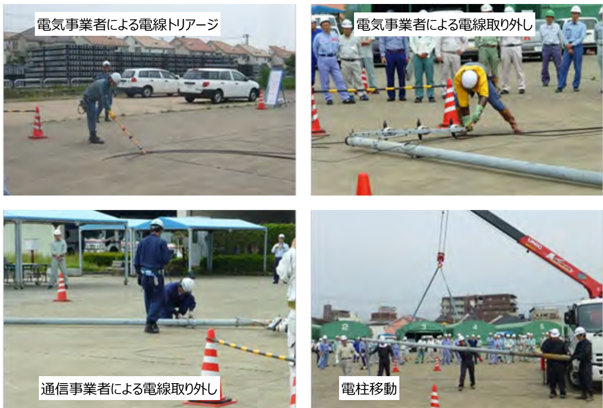
図 4.28 電柱の移動に関する作業例
