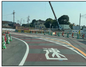
①現況写真
