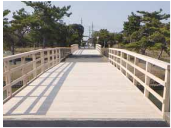
蓮沼海浜公園、山武市蓮沼ホ(水の広場木橋改修工)
