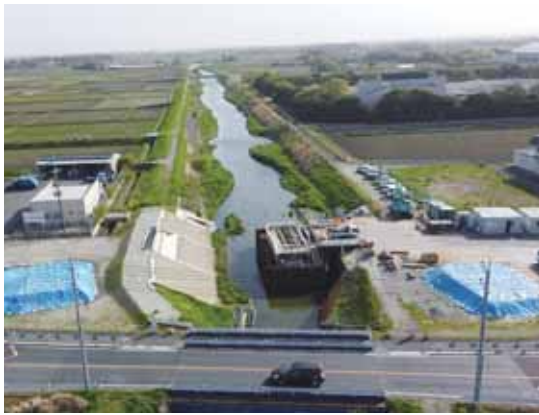
二級河川真亀川水系真亀川、東金市家徳(中橋下部工)
