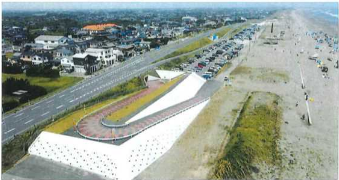
九十九里・南九十九里二号地区海岸 (不動堂海岸) 山武郡九十九里町不動堂 (囲み堤防乗越道路)
