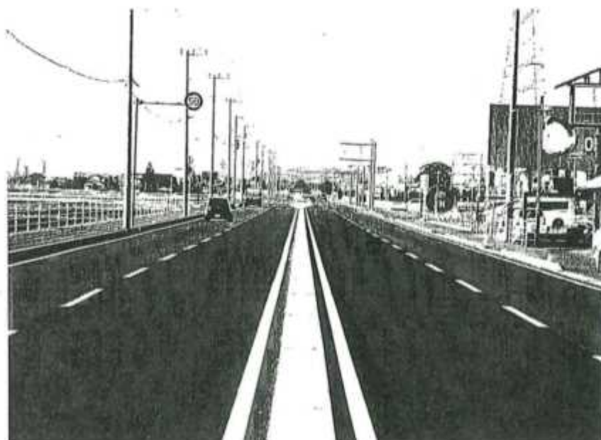
(国) 128号 大網白里市富田 (車道の4車線化)
