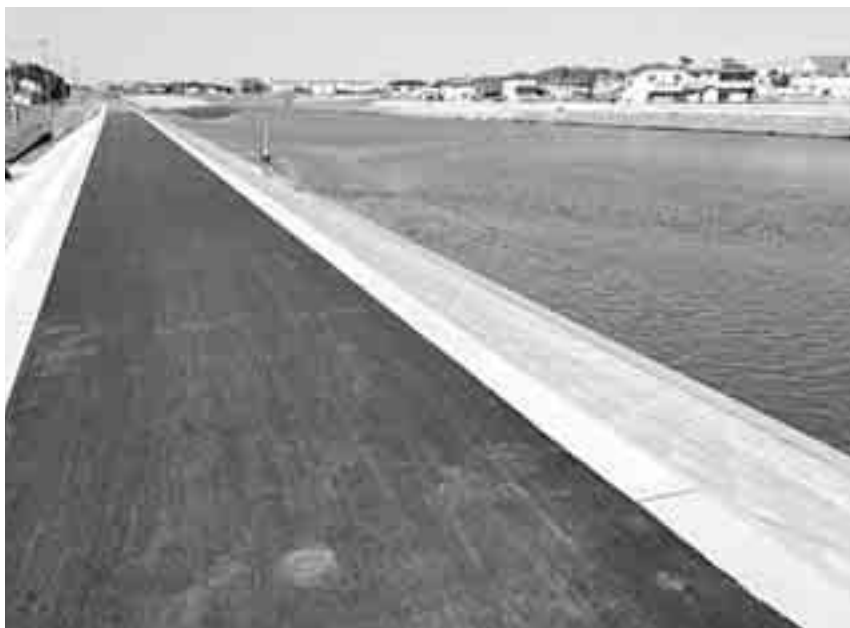
広域河川改修（復興） 事業（真亀川）、 山武郡九十九里町真亀
