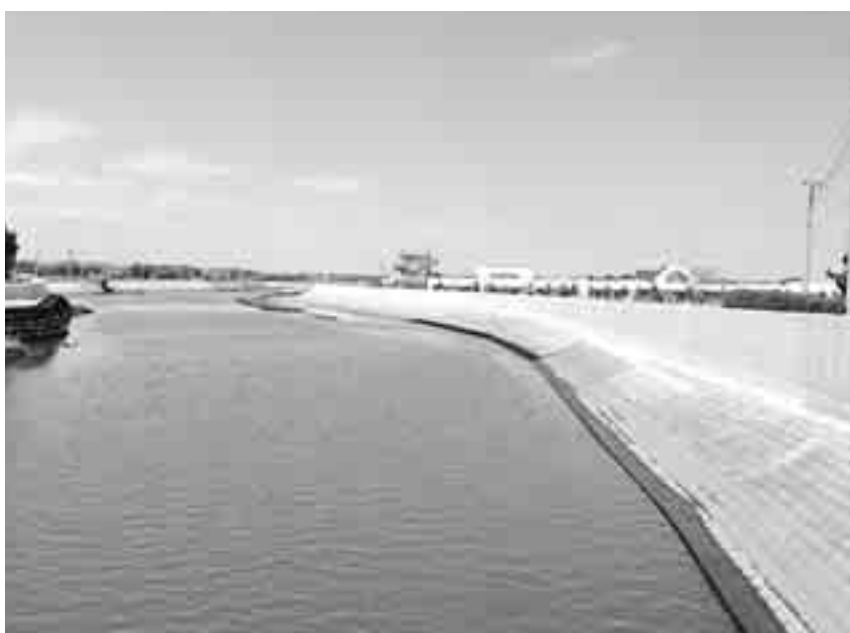
広域河川改修（復興） 事業（木戸川）、 山武市木戸
